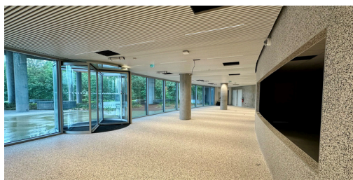
Cafétéria deux vues de l'espace en cours d'aménagement (installation du mobilier à venir)
